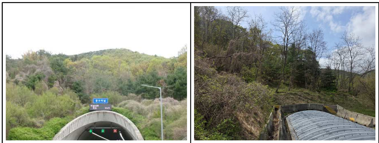
【사진 6.3.8】 사면 전경
